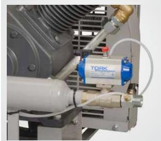
O pressostato de entrada de ar controla quando o Booster deve ser acionado e a válvula solenoide garante a passagem de ar comprimido para o compressor
