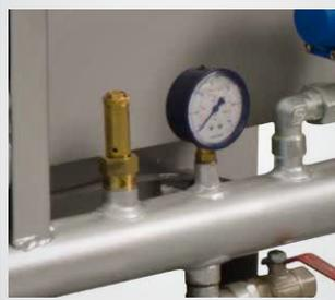
Manômetros de indicação da pressão de entrada e saída do ar comprimido instalados no Booster
